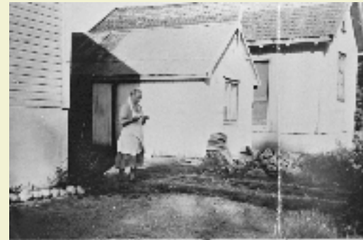
Stokke elverks gamle kontorbygning. Bygningen inneholdt kontor og verksted.
