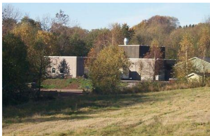
Vårnes renseanlegg er kommunens hovedrenseanlegg.
